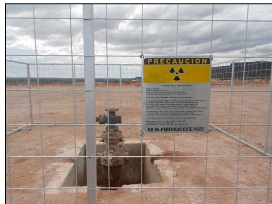
Cartel en Boca de pozo
