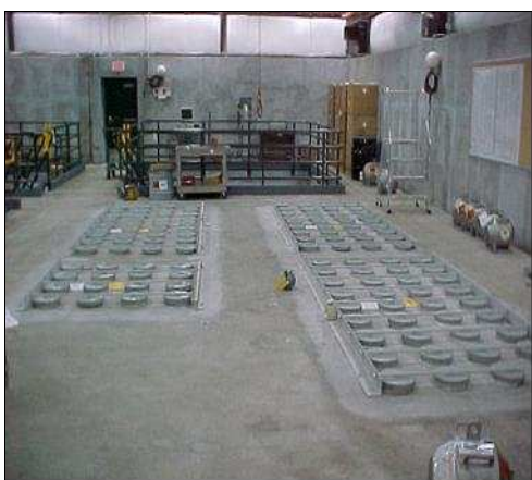
Almacenamiento en perforaciones tubulares
