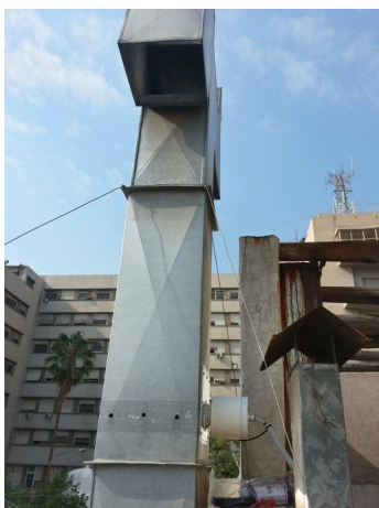
Ilustración 8: GM para detección de descargas atmosféricas
