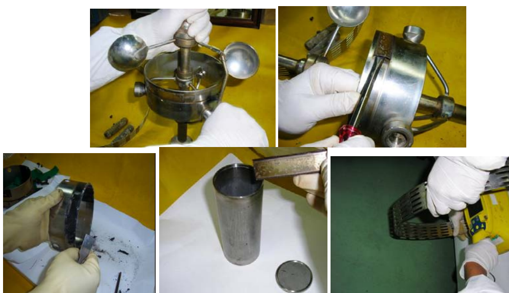
Fig. 7 Desmantelamiento del pararrayos Ionocaptor
