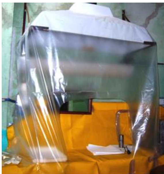
Fig. 2. Puesto de trabajo para el desmantelamiento de pararrayos
