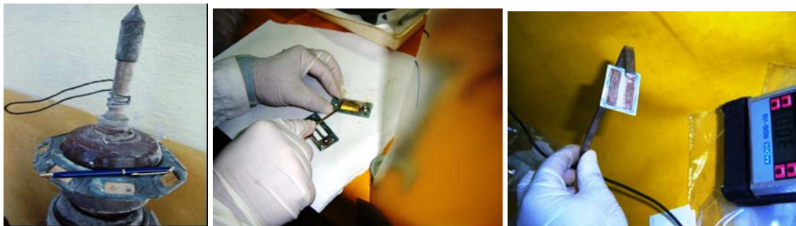
Fig. 9 Desmantelamiento del pararrayos SAREF, modelo Richard Girona
